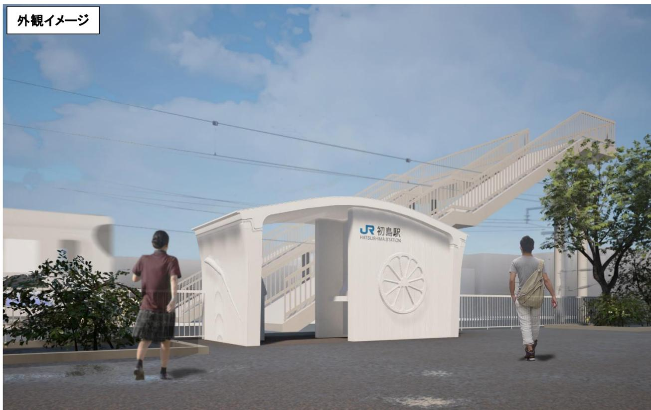
初島駅の完成イメージ。鉄筋コンクリート造の10平方メートル弱の平屋建て駅舎。
